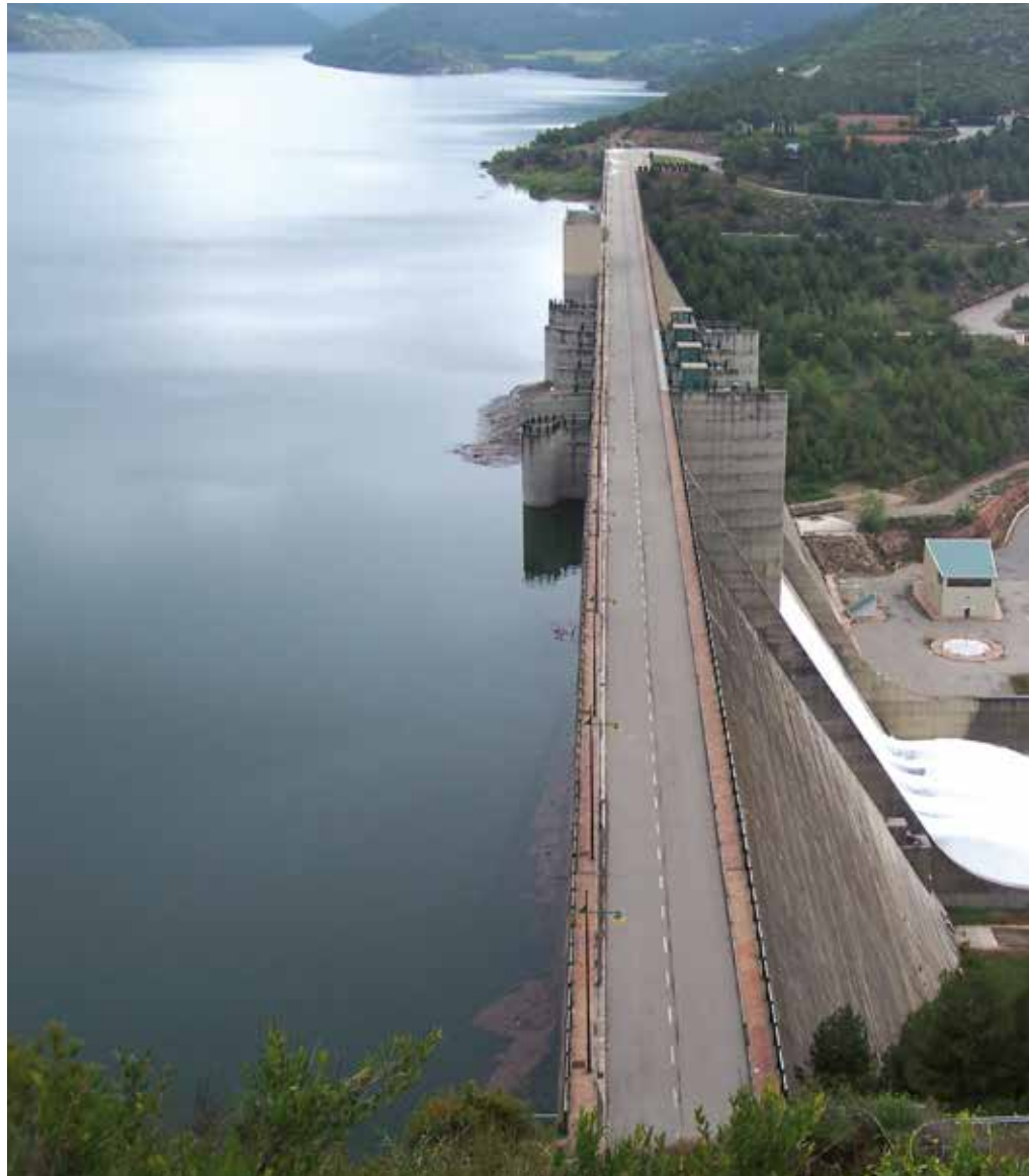
Preses de Rialb. Capçalera vista des del mirador del pantà (carretera de Ponts a Tremp).
